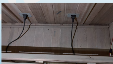
8.1. Connexion du cordon d'alimentation interne du banc 8.2. Connexion du cordon d'alimentation de la bande lumineuse LED sous le plateau de siège
