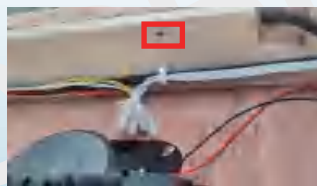
Après connexion des câbles, stabiliser le cadre avec des vis ST4×40 mm (4 pièces).
