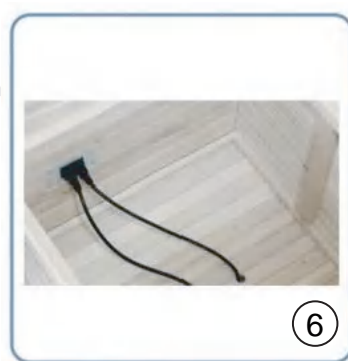
Étape 6 : Installer la prise (chauffage du repose-pieds)
